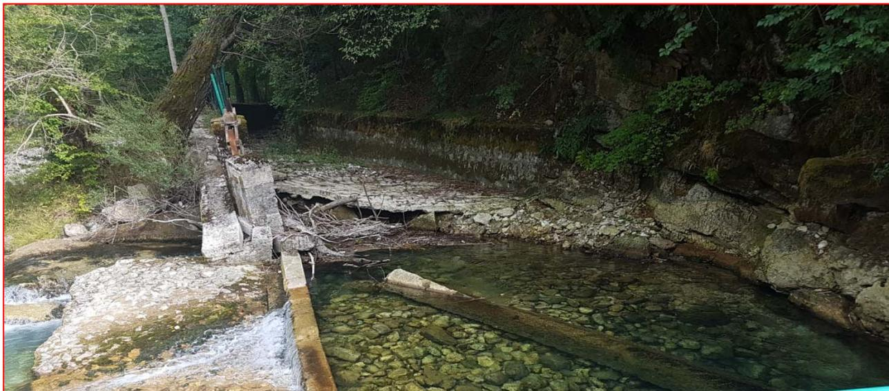
Fig.2.1.c Primo piano dei danni in corrispondenza della soglia del canale di derivazione
