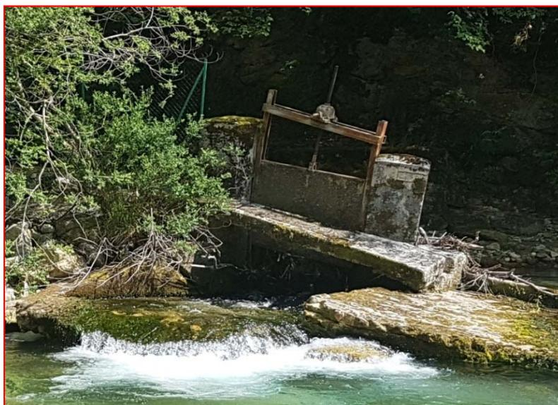
*Fig.2.1.b Primo piano della paraoia di troppo pieno con la torsione dei binari, del meccanismo di apertura e della lamiera che regola il deflusso*
