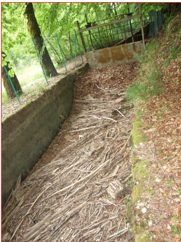
Fig.2.2.f Canale di derivazione -Accumulo di materiale in corrispondenza della paratoia di chiusura
