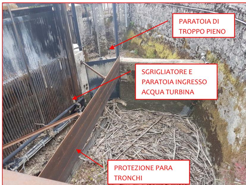
Fig.2.3.b Sistema di paratoie per la gestione dell'acqua in centrale
