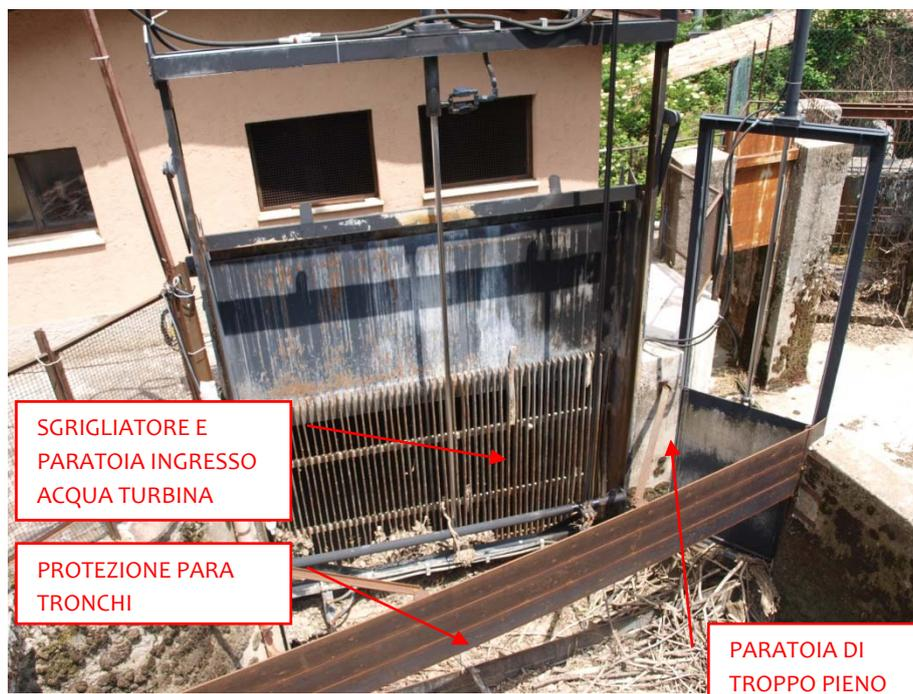
Fig.2.3.c Sistema di paratoie per la gestione dell'acqua in centrale
