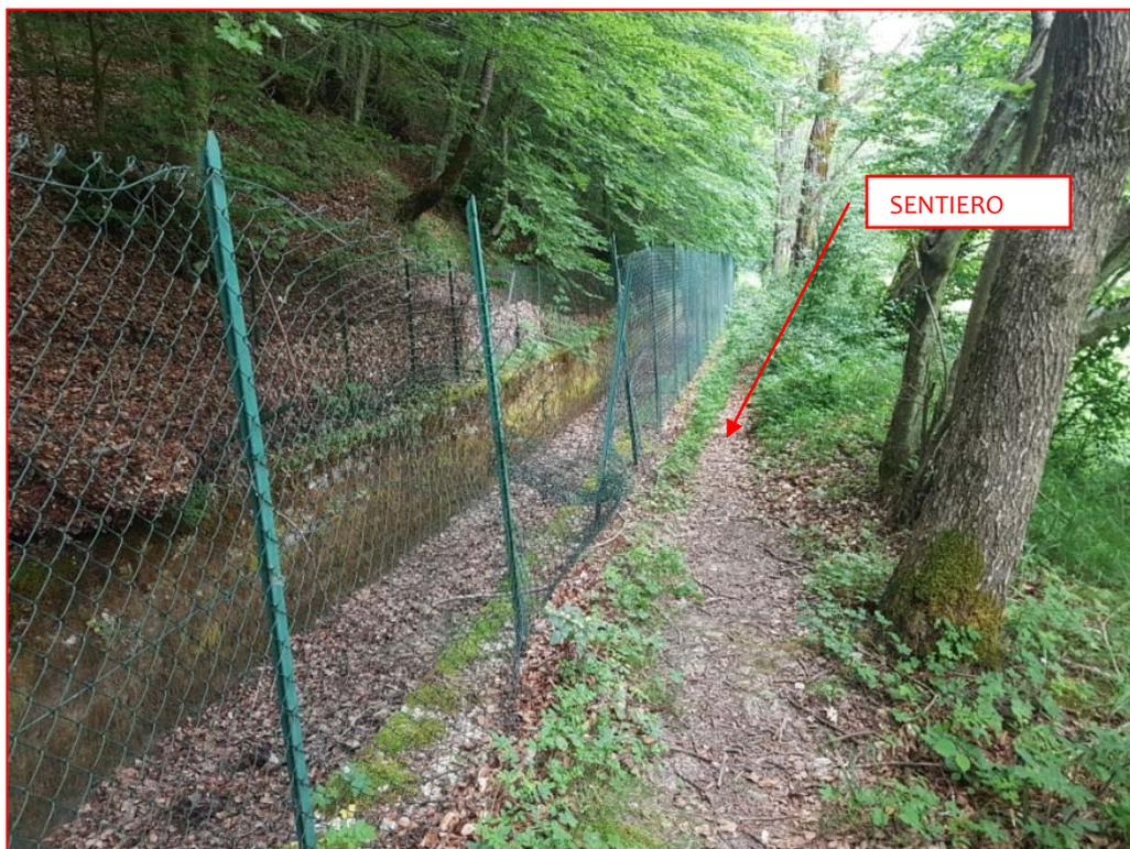
Fig.2.2.b Canale di derivazione -tratto di recinzione da ripristinare
