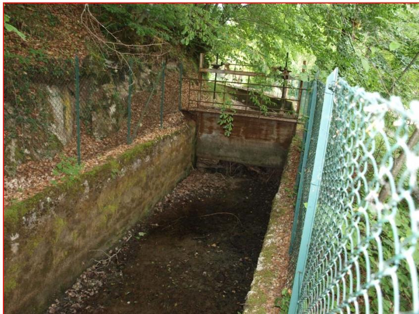
Fig.2.2.d Canale di derivazione -Paratoia di chiusura deflusso
