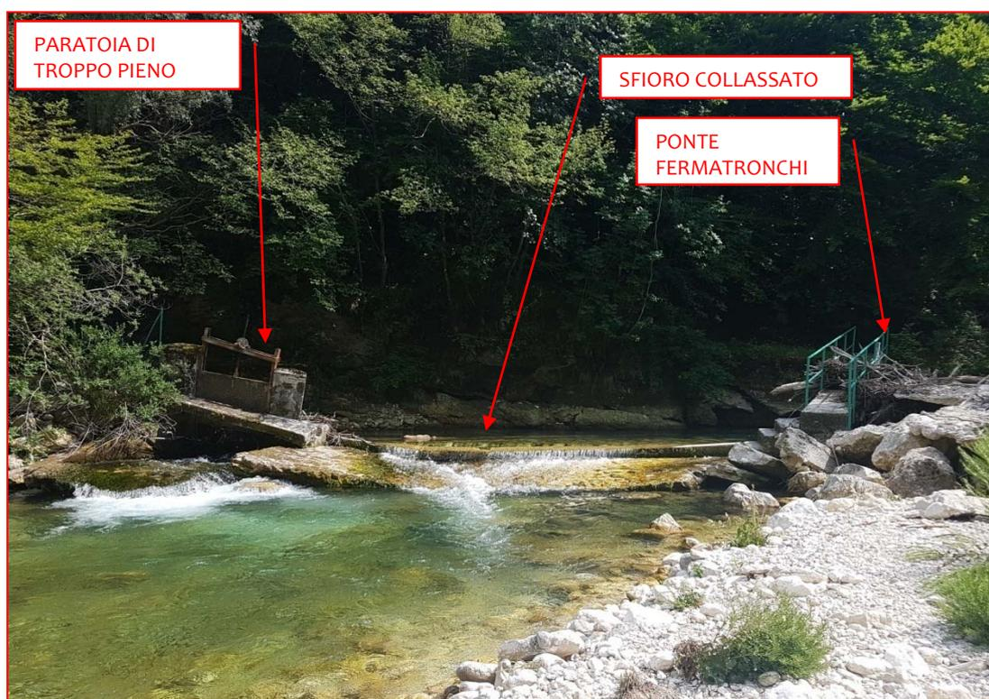
Fig.2.1.a Sfiato collassato in corrispondenza dell'opera di presa
