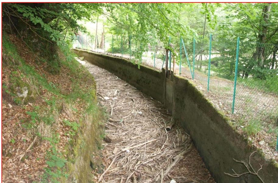
Fig.2.2.e Canale di derivazione -Paratoia laterale di scarico
